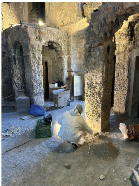
Restaurátorské práce na Skalce. Foto: Turistická oblast Brdy a Podbrdsko
